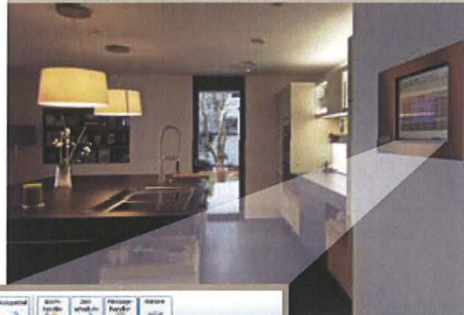
ZENTRALE: Das Touchpanel befindet sich an zentraler Lage, unmittelbar bei der Kochinsel. Über den «Home Building Manager» können alle Funktionen abgelesen und gesteuert werden.
