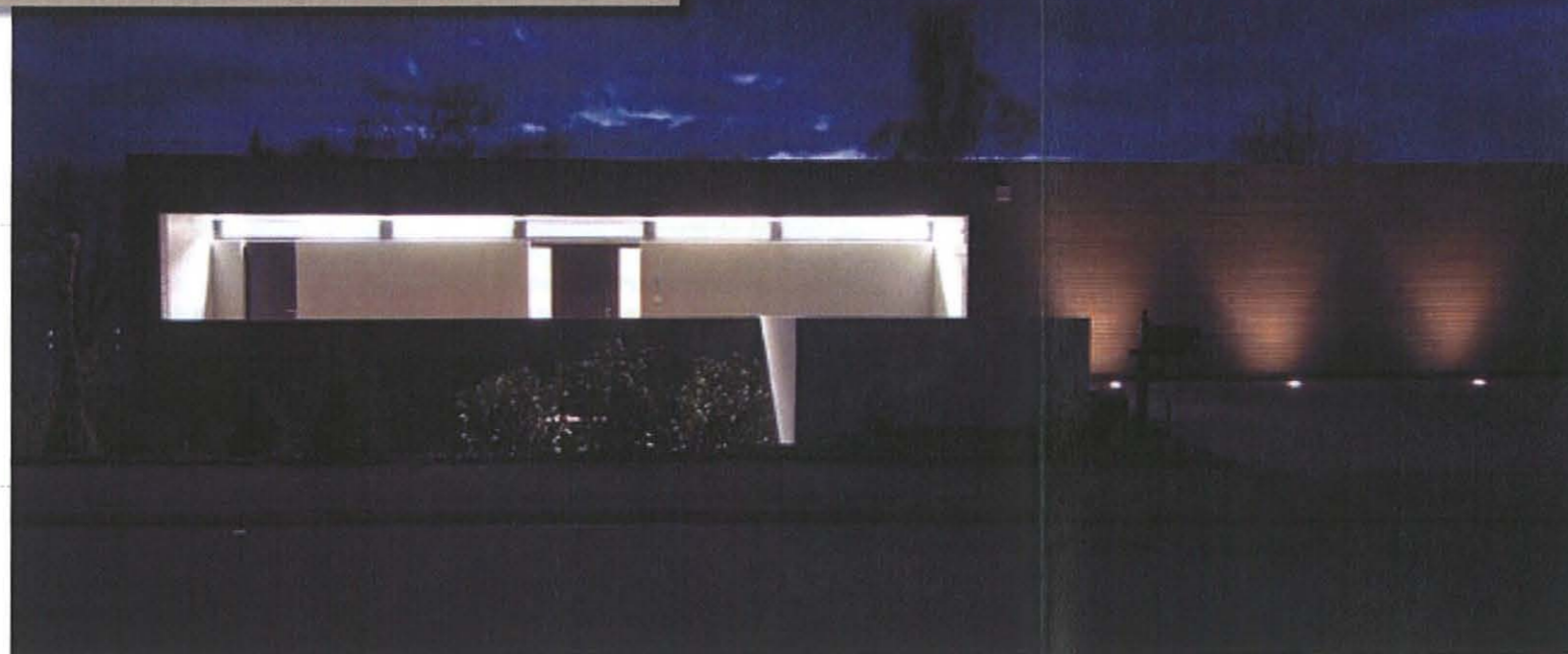
KOSTEN/NUTZEN: Die Lösung in diesem Umbau für Intelligentes Wohnen ist komplett mit entsprechendem Budget. Sie unterstützt neben Komfort und Energieeffizienz auch die Ästhetik des Gebäudes, die klare und ungestörte Formensprache, und bietet für die nächsten 20 Jahre die Nutzung aller Dienste ohne bauliche Eingriffe.
